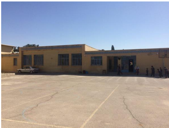
شکل ۶. وضعیت نامناسب طراحی فضای باز در دبستان ناشنوایان در شهر اصفهان (مرکز شماره ۱)
